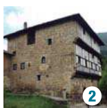
2 Apeztegiarra dorrea Casa torre Apeztegiarra (Betelu)
